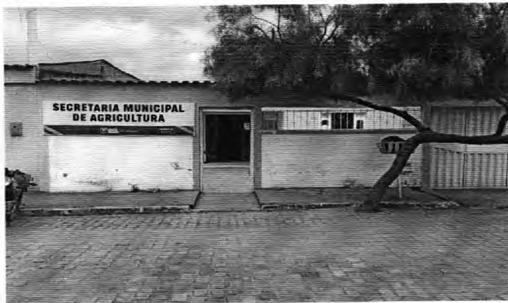
FOTO 1: Fachada principal da Secretaria Municipal de Agricultura.
