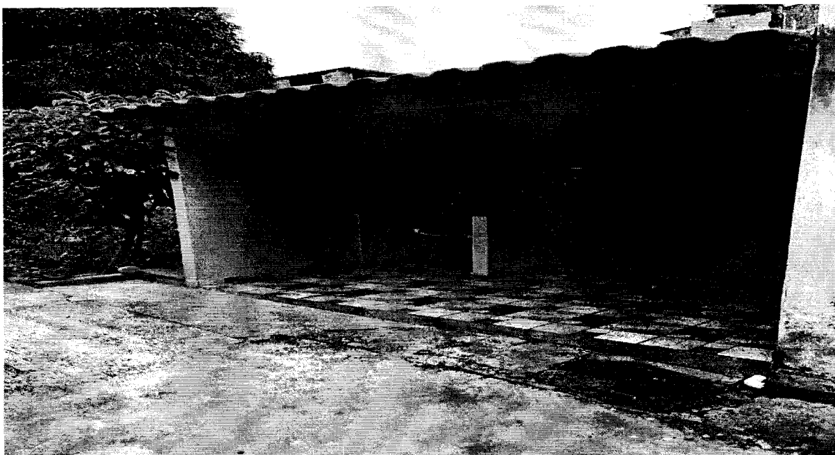
FOTO 08: Área de serviço.
