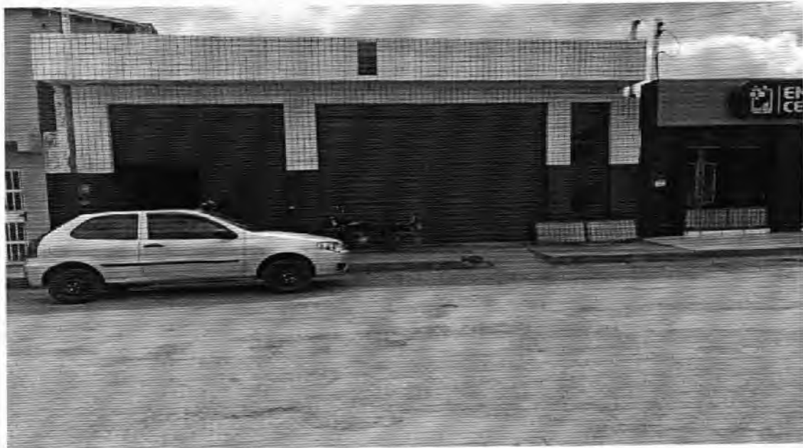
FOTO 1: Fachada principal do Almoarifado da Secretaria de Saúde.
